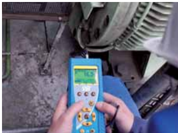
Monitoring mazání ložisek
