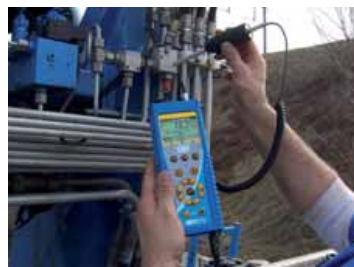
Inspekce hydraulických systémů
